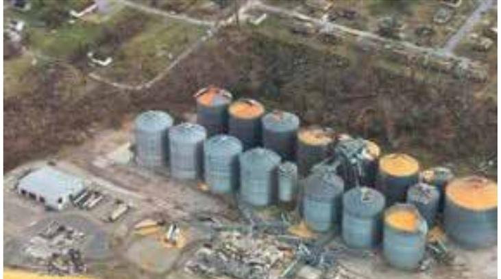
de aparece presión externa sobre el silo, mientras que en todo el resto de la superficie aparece succión, esto determinará la forma de los modos de pandeo resultantes.
