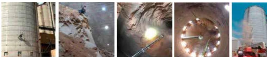
Qué pasa si se detecta un foco de calentamiento de granos dentro de un silo de éstos? Si no se actúa rápido, ese foco contaminante se extiende. Semejante masa enorme de granos (20 o 30 mil toneladas) no se enfría fácil con aireación, hay que trasilar casi todo el silo. Para ello se debe disponer de un espacio equivalente en otros silos. Y si no se dispone de ese espacio? El problema puede ser muy serio y muy costoso. “Lo barato sale caro”.
