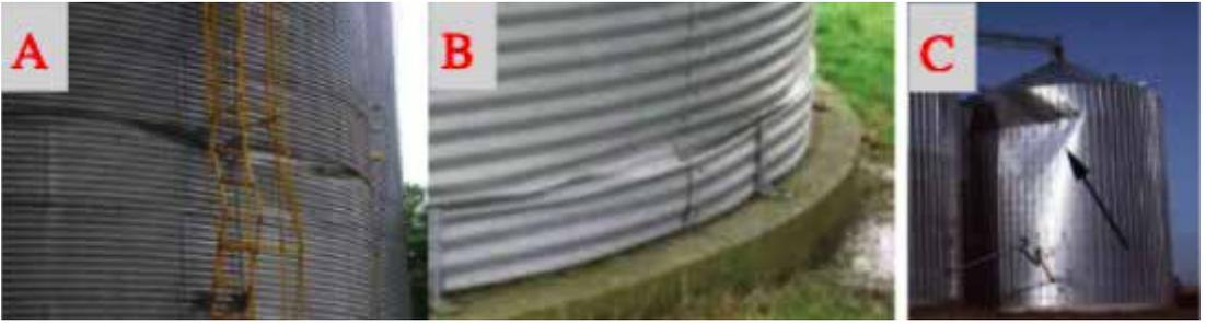
bre las propiedades físicas del producto almacenado y la influencia de la humedad en el comportamiento de las tensiones dentro del producto que afectan significativamente las presiones, pueden conducir al colapso estructural. Son los problemas mas evidentes en el estudio de las causas de los accidentes y colapsos de silos.
